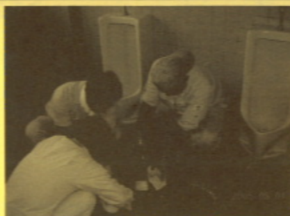
上：小便器ワゴン付着尿石除去作業
